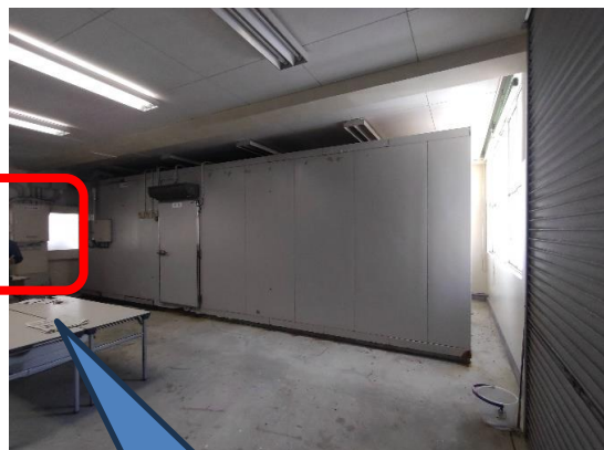
③室内(冷凍庫室)
