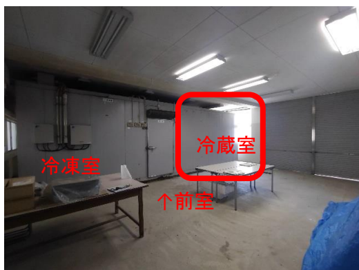
②室内(B棟 1階 冷凍庫室)
