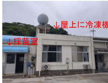
②採苗棟正面
