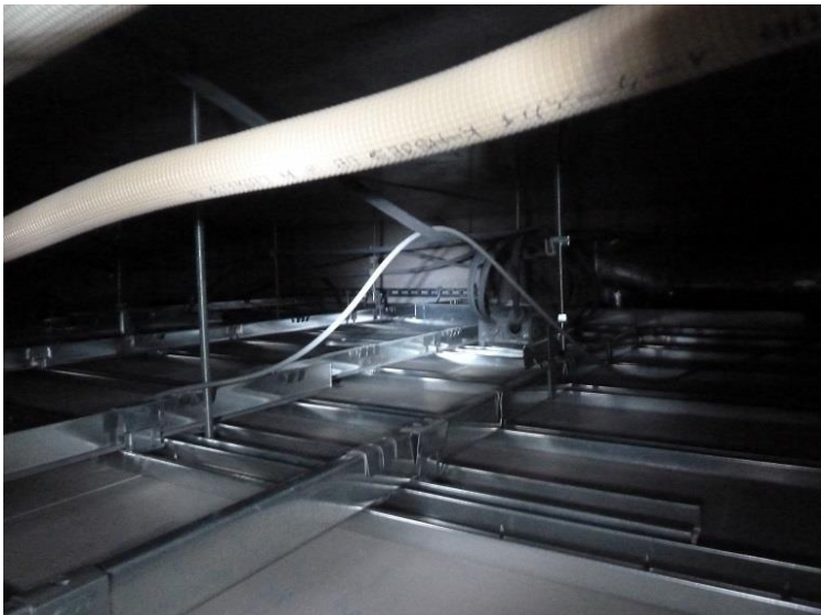
②天吊りプロジェクタ(天井内)
