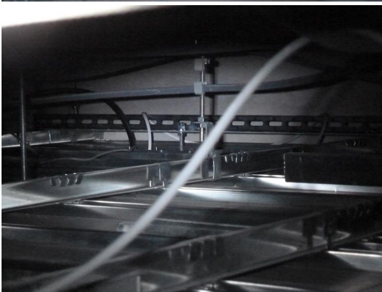
③天吊りプロジェクタ(天井内)
